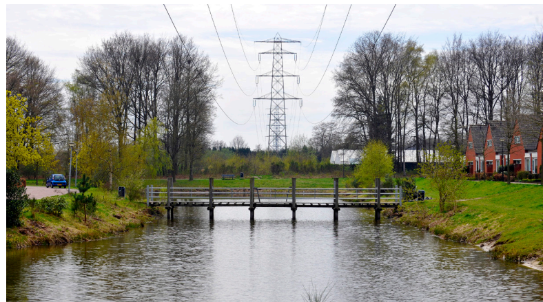
Hoogspanningskabels Apeldoorn Zuid
